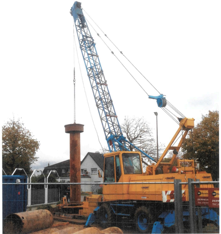
Aushub des Schluckbrunnens
