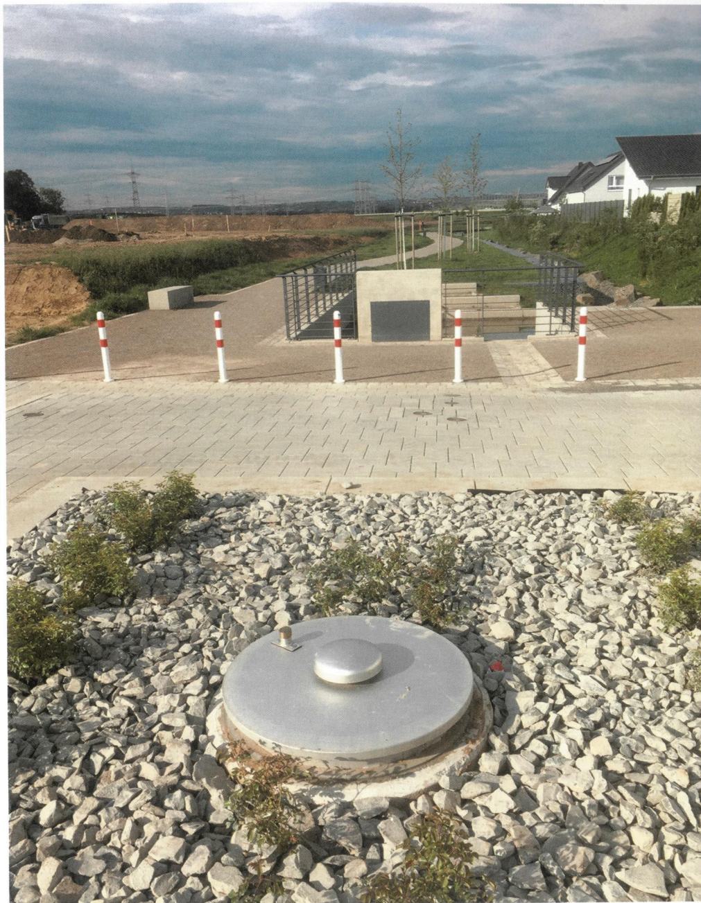
Schachtabdeckung des Saugbrunnens
