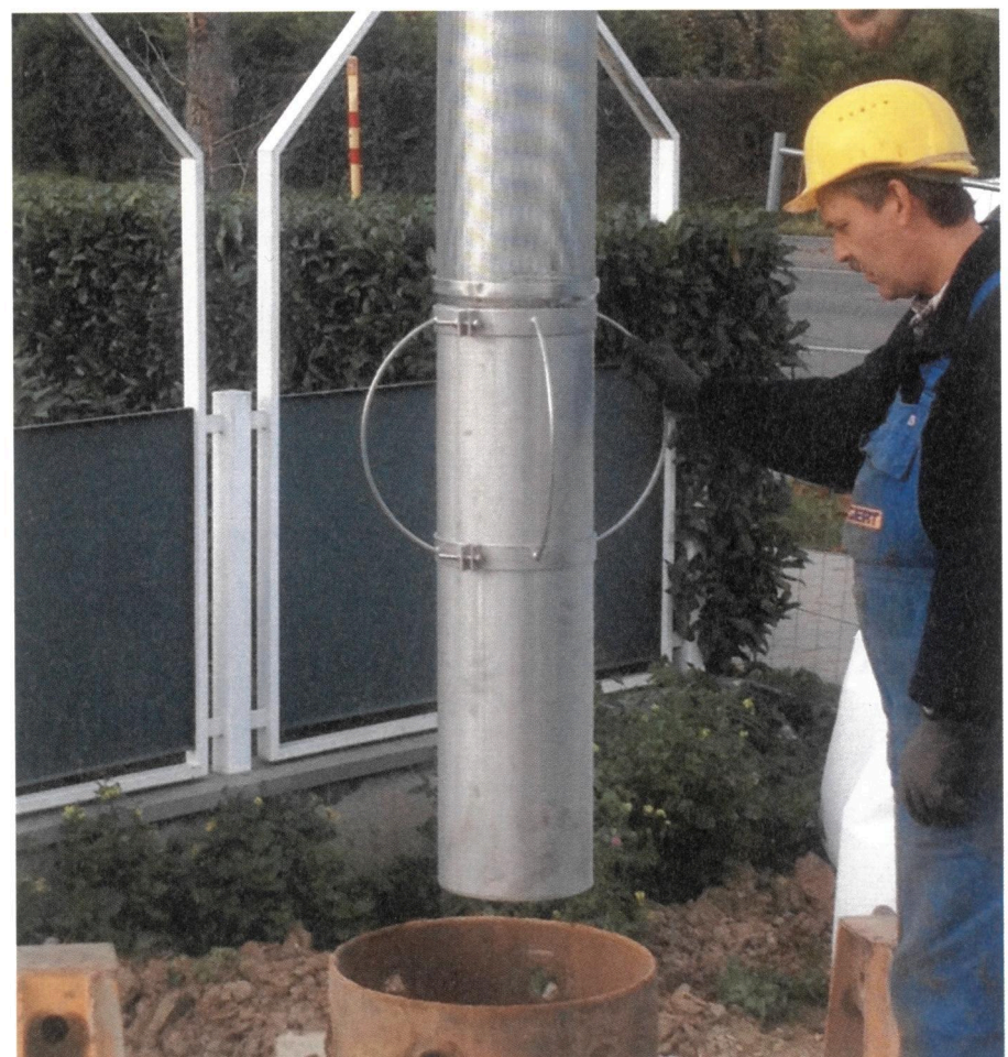
Einbringen des Filterrohres
